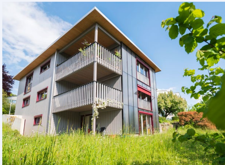
Il sottotetto è stato sostituito con una struttura in legno e trasformato in appartamento, nel seminterrato verso la collina si è ricavato un monolocale.
